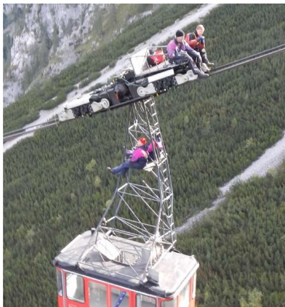
Рисунок 3-10: Визуальный контроль направляющих канатов в положении сидя или лежа на специальной платформе
