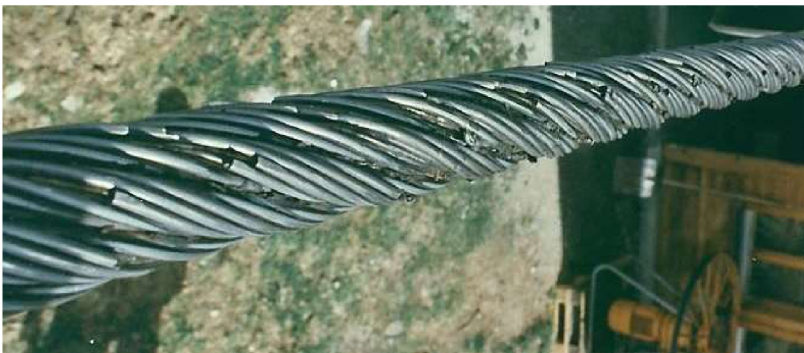
Рисунок 2-2: Повреждения, вызванные проскальзыванием крепежного зажима
