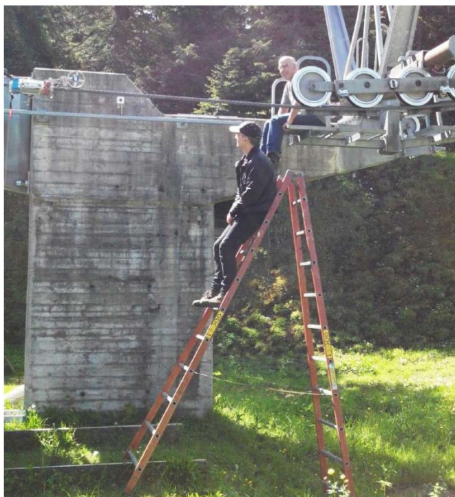
Рисунок 4-30: Условия в месте проведения работ на нижней станции второй установки
