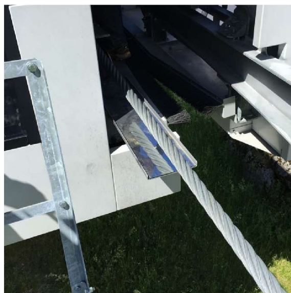
Рисунок 3-12: Зеркало у стандартной модульной станции для одноканатной подвесной дороги (вид снаружи)
