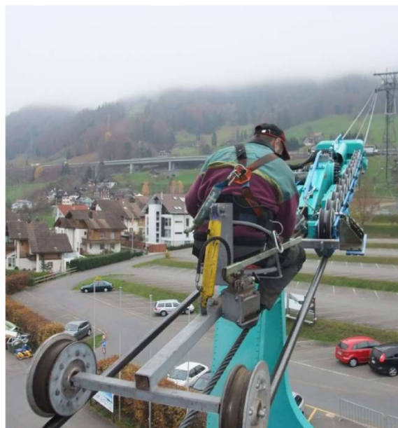
Рисунок 3-11: Визуальный контроль направляющих канатов со специального сиденья
