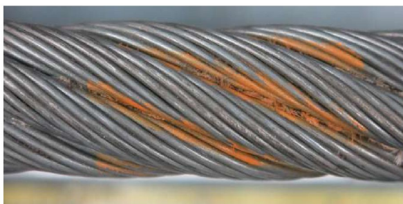
Рисунок 4-21: Коррозия в зоне контакта прядей
