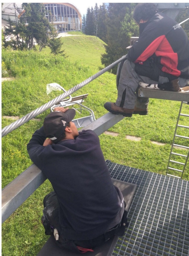
Рисунок 4-31: Условия в месте проведения работ на верхней станции второй установки
