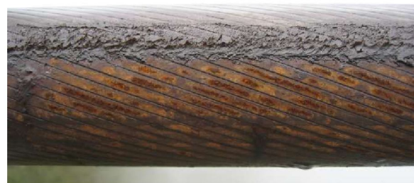
Рисунок 4-18: Коррозия на канате полностью закрытой конструкции
