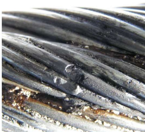
Рисунок 2-4: Повреждения из-за прохождения тока
