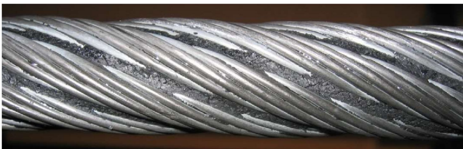
Рисунок 6-14: Грязь в зоне контакта прядей - контроль затруднен
